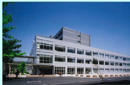
理学部B・C棟改修
